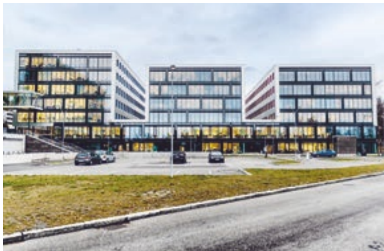
INNOVASJONSPARKEN ligger på Ullern i Oslo, like ved Ring 3 og Radiumhospitalet. Ullern videregående holder til i den nederste delen av bygget, mens de tre høye modulene huser henholdsvis Oslo Universitetssykehus (t.v.), Kreftregisteret og Oslo Cancer Cluster inkubator.
